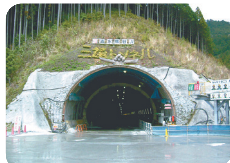
三遠トンネル引佐側坑口
